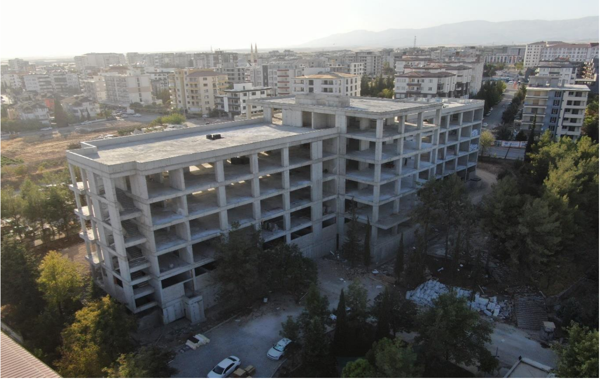
Resim: İnşaatı Devam Eden Dış Hekimliği Uygulama ve Araştırma Merkezi Binası
